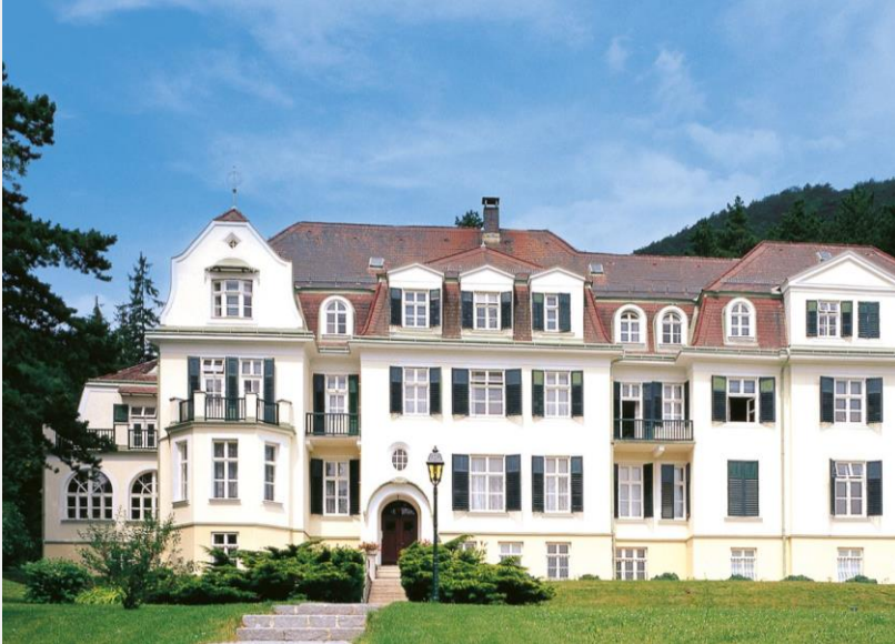
Unsere Firmenzentrale in Wopfing, Österreich
